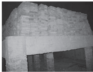
图 12 夹芯材料填充楼板加载图
