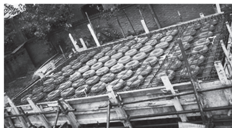
图 8 夹芯材料填充楼板现场图
