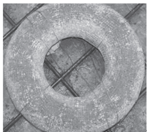
图 7 夹芯材料圆环体的固定
